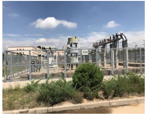
站内地面绿化、硬化
